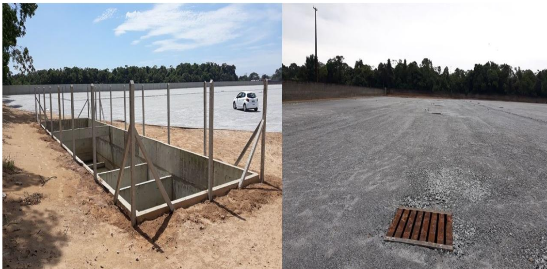
Figura 16 Sistema de drenagem implantado na Araguaia.
